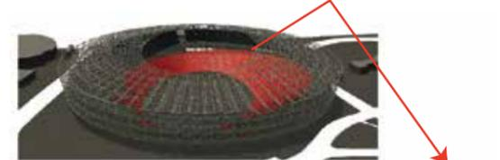
スタンドを既存席のほかに3万席を仮設により増設。オリンピック終了後は、解体した仮設構造体を津波が予測される東海、東南海地震に備えて移築し60力所で恒久的な津波タワーとして生まれ変わる。
