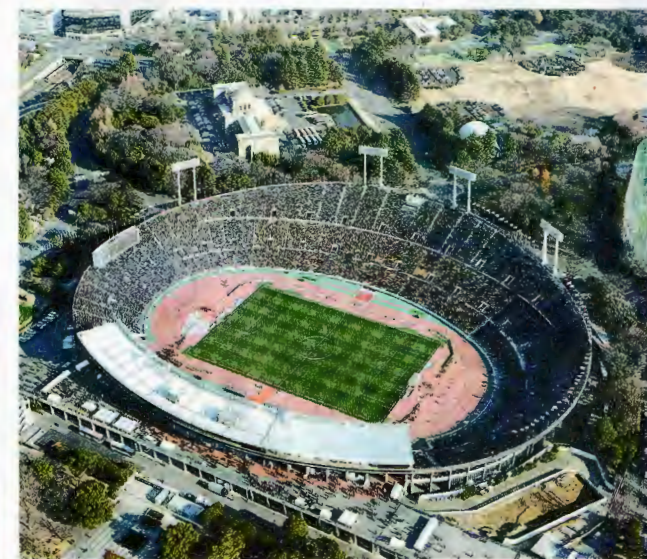
解体される前の国立競技場。2014年1月1日、新宿区で、本社へ「おおづる」から
