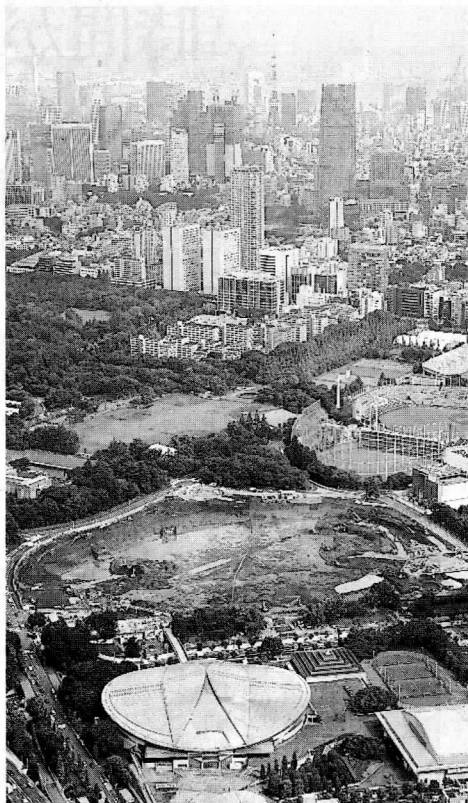
スタジアムが解体され更地になった国立競技場跡地=7月、本社ヘリから
